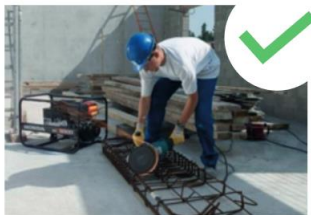
Groupe électrogène à l'extérieur.
