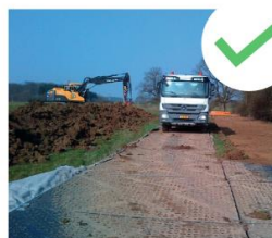
Piste de chantier temporaire stabilisée, (dégagement de poussières faible).
